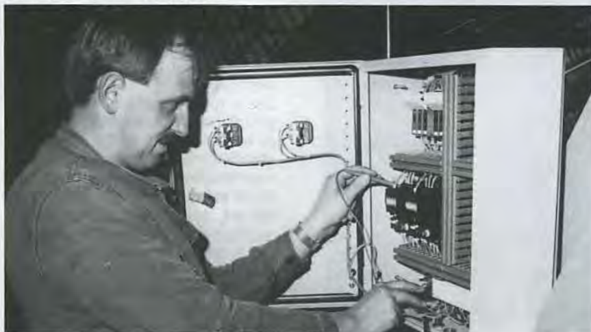
Une intervention dans un coffret électrique.
